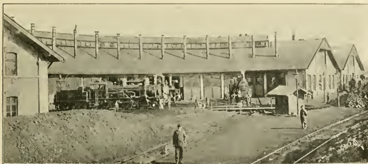
Abb. 402. Heizhausanlage [rotundenförmige] auf dem Franz Josef-Bahnhöfe in Wien. [Nach einer Original-Aufnahme von A. Stempf.]
